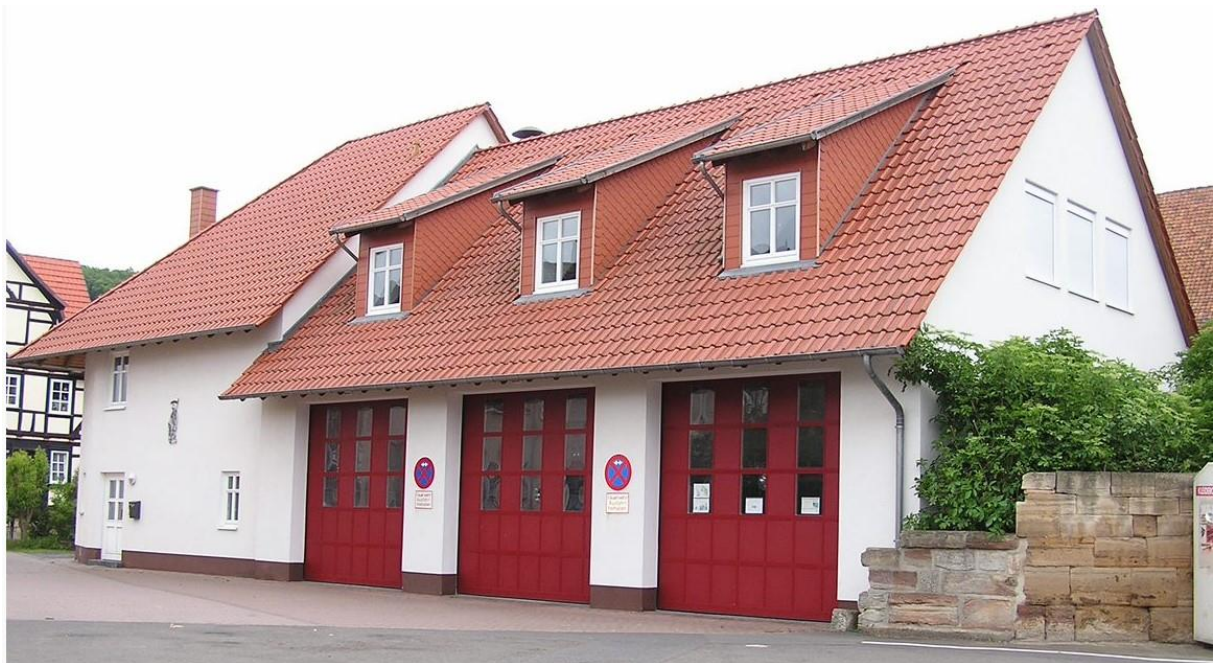
Das neue Feuerwehrhaus an der Kirchstraße
