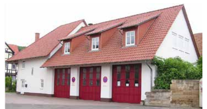
Das neue Feuerwehrhaus an der Kirchstraße
