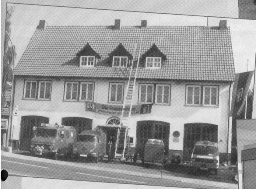
Das alte Feuerwehrgerätehaus in der Neueroder Straße ...
